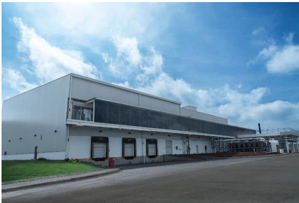
Vista Frontal Planta OTC y Área de descarga
