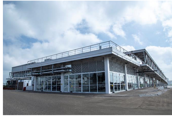
Cuarto de Máquinas Planta OTC Vista Frontal
