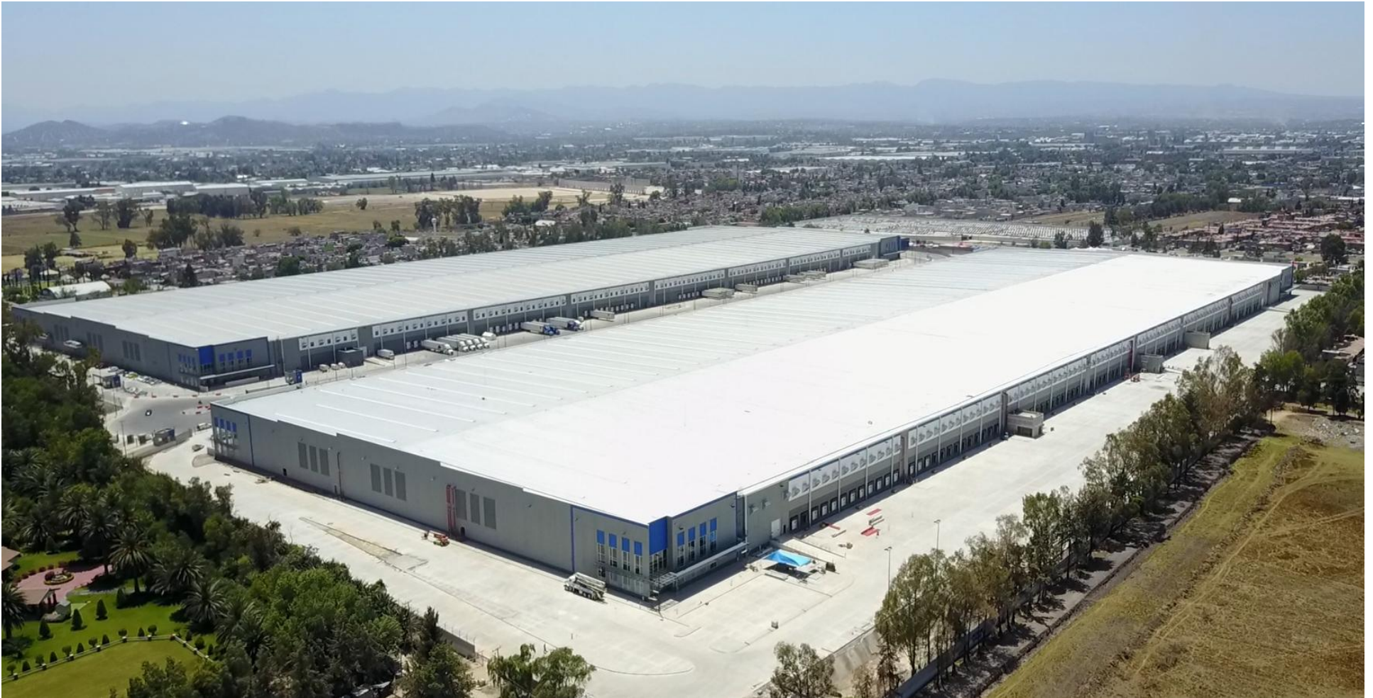
Parque Industrial Danhos Cuautitlán I (Nave I y Nave II)
