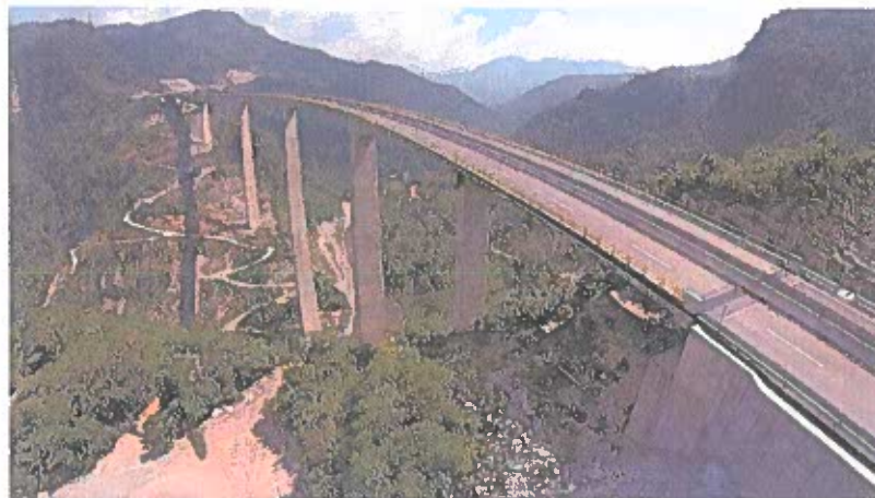
Puente Ing. Gilberto Borja Navarrete, estructura más alta y larga del proyecto con una longitud de 850 (ochocientos cincuenta) metros y una altura en su punto más alto de 225 (doscientos veinticinco) metros, ubicado en el Km. 163+147.
