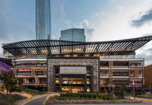
EL PALACIO DE HIERRO COYOACÁN
